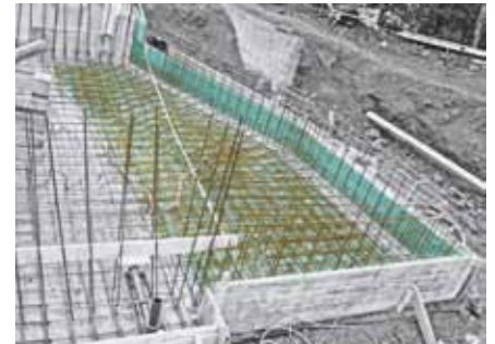
Medence alapzatának hőszigetelése FIBRANxps 400-L
