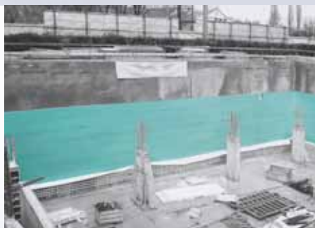
Hőszigetelő rendszer alkalmazása egy város központi építkezésen »inverz építés«
