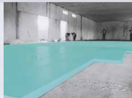
Egy ipari raktárhelyiség padló hőszigetelése FIBRAN xps 300-L
