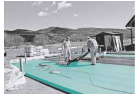
Energia takarékos ház alapzatának hőszigetelése FIBRANxps 400-L
