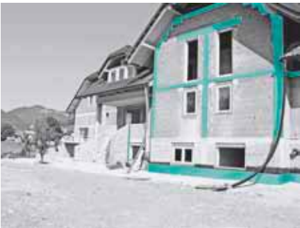
Földrendésvédelmi kötések és gerendák hőhidainak hőszigetelése FIBRANxps ETICS
