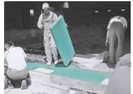
Magas terhelésű padló hőszigetelése. FIBRANxps 500-L
