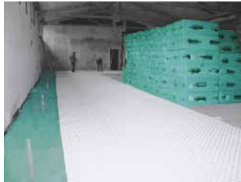
FIBRANxps 300-I Hőszigetelő a padlófűtés alatt
