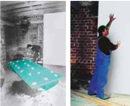
FIBRANxps FABRIC Belső szigetelés gipszkartonnal kombinálva
