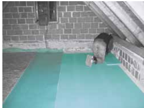
Szárazépítésű padlás- födém szigetelése FIBRANxps 300-I lapokkal, és FIBRANxpe lépéshangszigeteléssel
