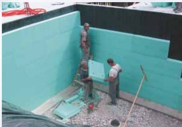
FIBRANxps 300-L lapok rögzítése FIBRANstick butyl ragasztóval.
