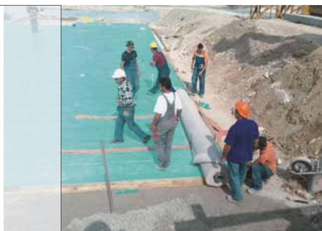
Részletrajz 8 - Környezetbarát betonit vízszigetelő elhelyezése a FIBRANxps 400-L lapokon az iskolaépület alaplemezének megépítése előtt.
