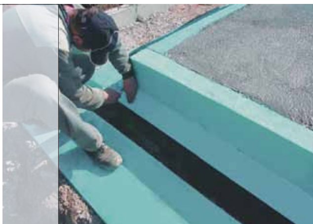
Részletrajz 9 - Vízszigetelés két réteg FIBRANxps 400-L szigetelő lap között. Sarokléc használata a vízszintes bitumenes vízszigetelő belső sarkainak lesimításához.
