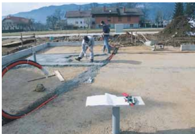
Függőleges beállítások, az alsó FIBRANxps 400 - L szigetelés alatti réteg kiegyenlítése, tömörítése.
