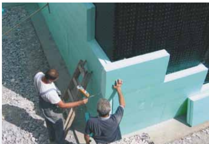
A FIBRANxps 300-L lapok keresztrögzítése sarkoknál.
