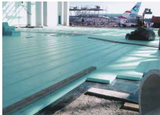
Repülőtérphangár alapjának hővédelme FIBRAN xps 700-L lapokkal.
