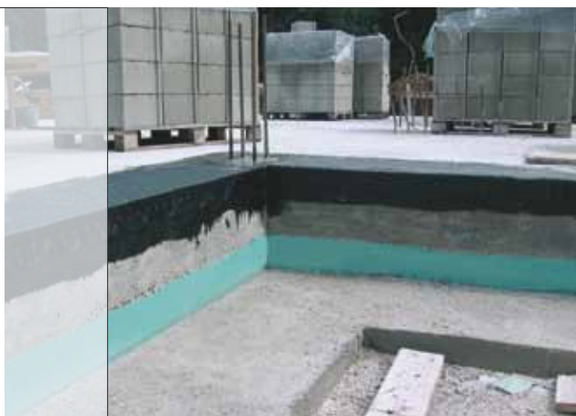
Részletrajz 10 - Pincével rendelkező épület bitumenes vízszigetelése az alaplemezen. FIBRANxps 400-L az alaplemez alatt.
