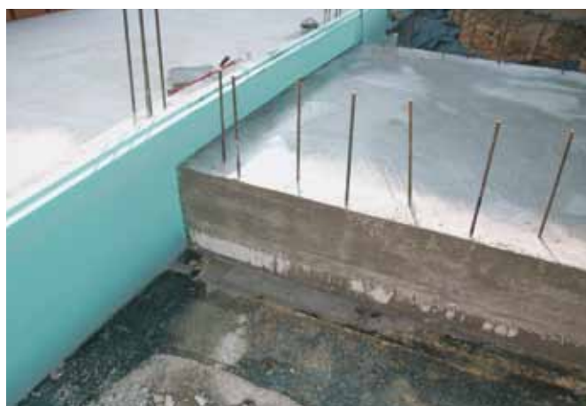
Részletraaj 3 - Az olyan előre gyártott elemeket, mint a fényakna a gyártó előírásainak megfelelően illik beépíteni. A fényakna beépítése során a szigetelő réteg megbontását körültekintően kell visszazárni. A fényakna hideg oldaláról a szerkezet megfelelő hőszigetelést igényelnek.
