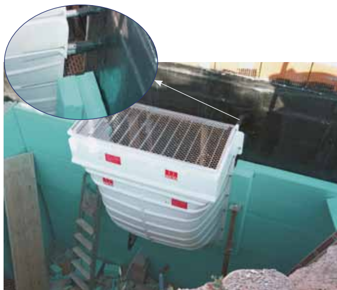
Részletraaj 3 - Az olyan előre gyártott elemeket, mint a fényakna a gyártó előírásainak megfelelően illik beépíteni. A fényakna beépítése során a szigetelő réteg megbontását körültekintően kell visszazárni. A fényakna hideg oldaláról a szerkezet megfelelő hőszigetelést igényelnek.
