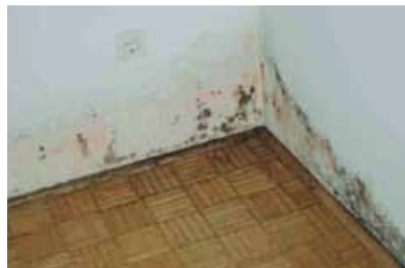
Szemmel látható nedvesség és egészségkárosító penészesedés a falon.
