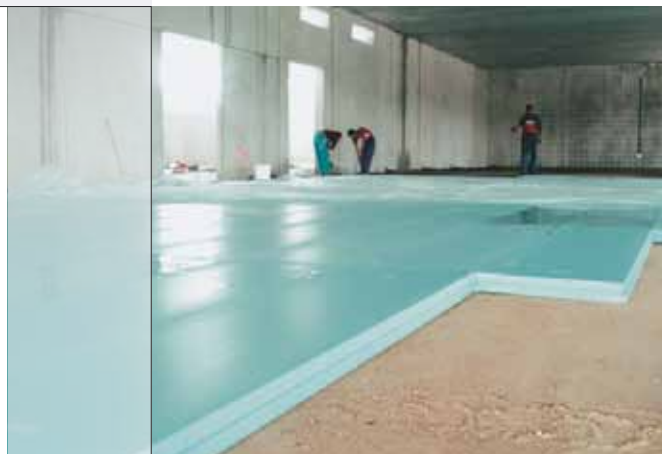
Részletrajz 5 - Ipari padló hőszigetelése FIBRANxps 500-L termékkel. Egyenlőtlen padló esetén a kiegyenlítés finom homokkal végezhető el.
