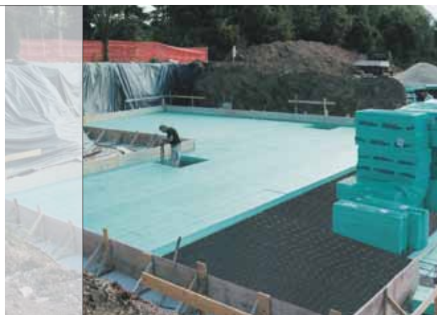
Részletrajz 7 - A tehereloszlás szabályai miatt – ahogy a részletek mutatják. Lakóépület alapjának hőszigetelése.
