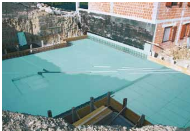
Vezetékezés a FIBRANxps előzetesen kialakított csatornáin keresztül.
