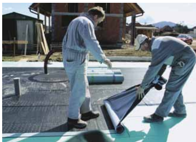
Öntapadó vízszigetelés elhelyezése a FIBRANxps 400-L hőszigetelő lapokon.
