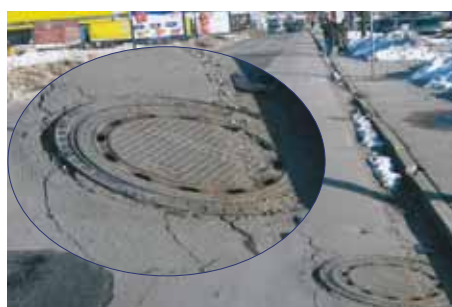
A mocsaras talaj elfagyása, vizesedése károkat okoz az út- és csatornahálózatokban.
