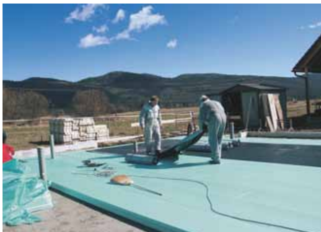
Öntapadó vízszigetelő két réteg FIBRANxps 400-L hőszigetelő lap között.
